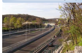
D2 Lamačská cesta – Staré grunty
