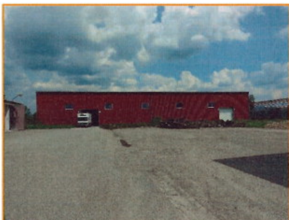
Obrázok 116. Skladová hala pohľad z prednej strany.
