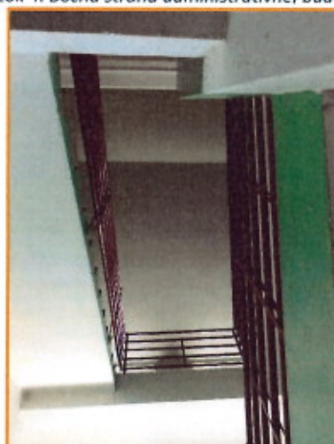
Obrázok 6. Schodisko administratívna budova.
